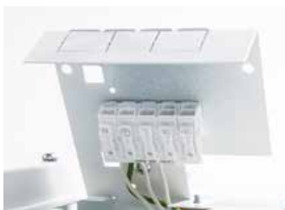
Монтаж на клеммную колодку (DALI)
